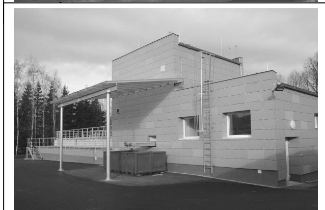
Obr.2. Úpravna vody Hajská po rekonstrukci
