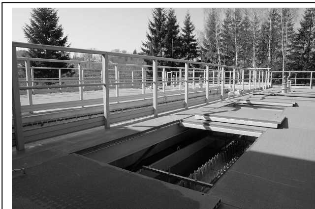
Obr.5. Sedimentace po rekonstrukci
