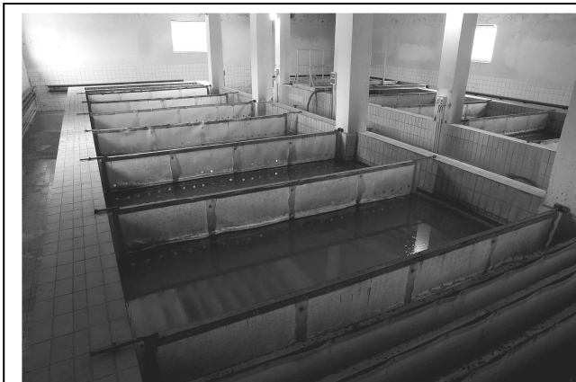
Obr.3. Sedimentace před rekonstrukcí
